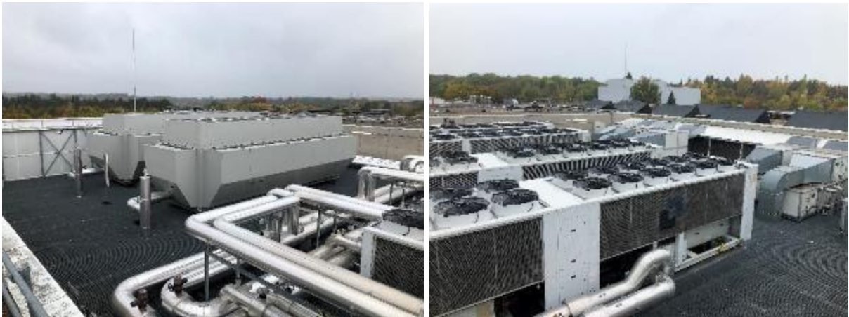
Figure 17 : Photographie des groupes froids en toiture du bâtiment T
