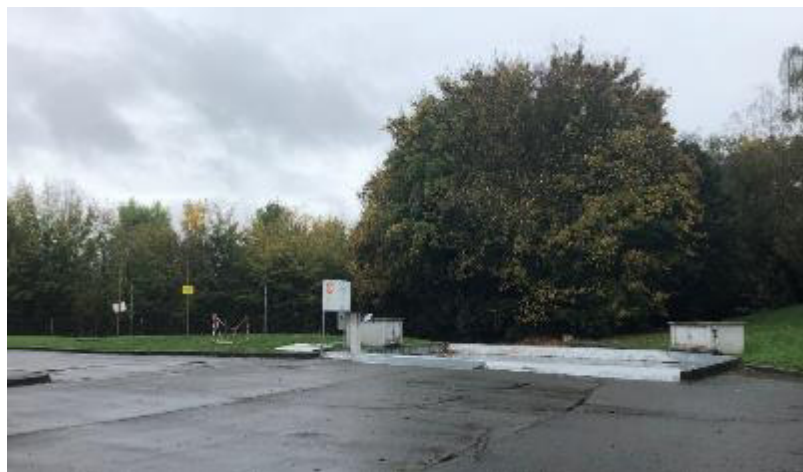
Figure 16 : Aire de dépotage de la partie Sud
