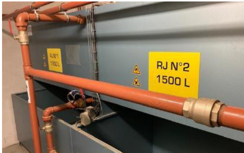
Figure 15 : Nourrices fioul présentes dans un local spécifique du bâtiment U
